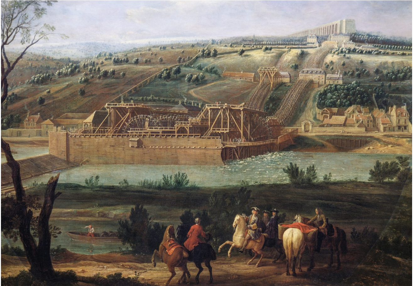
Die Maschine von Marly pumpte Wasser von der Seine zum 160 Meter höher gelegenen Aquädukt von Louveciennes.
